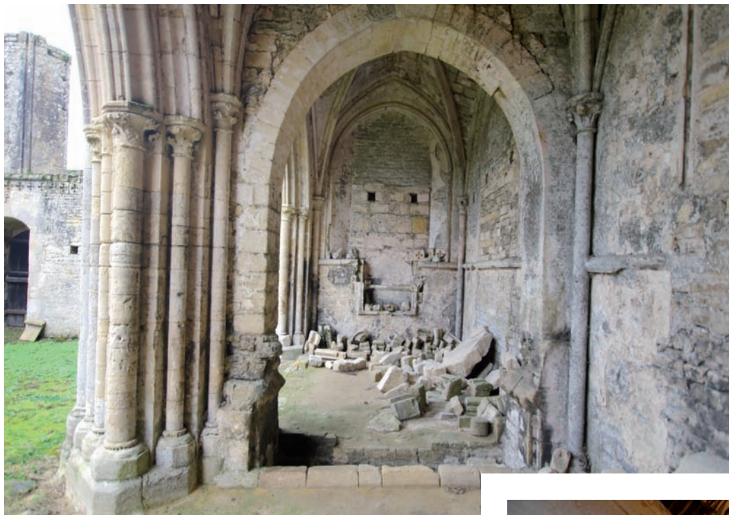
Les chapelles du bras nord du transept © SWG).
